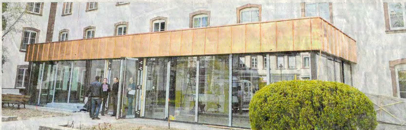
Une fois les travaux terminés, l'entrée de la maison de retraite de l'hôpital se fera côté rue du Château. PHOTOS DNA — F.K.
